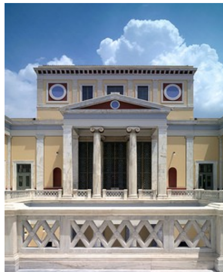
Ил. 4. «Авероф» – Школа архитектуры
